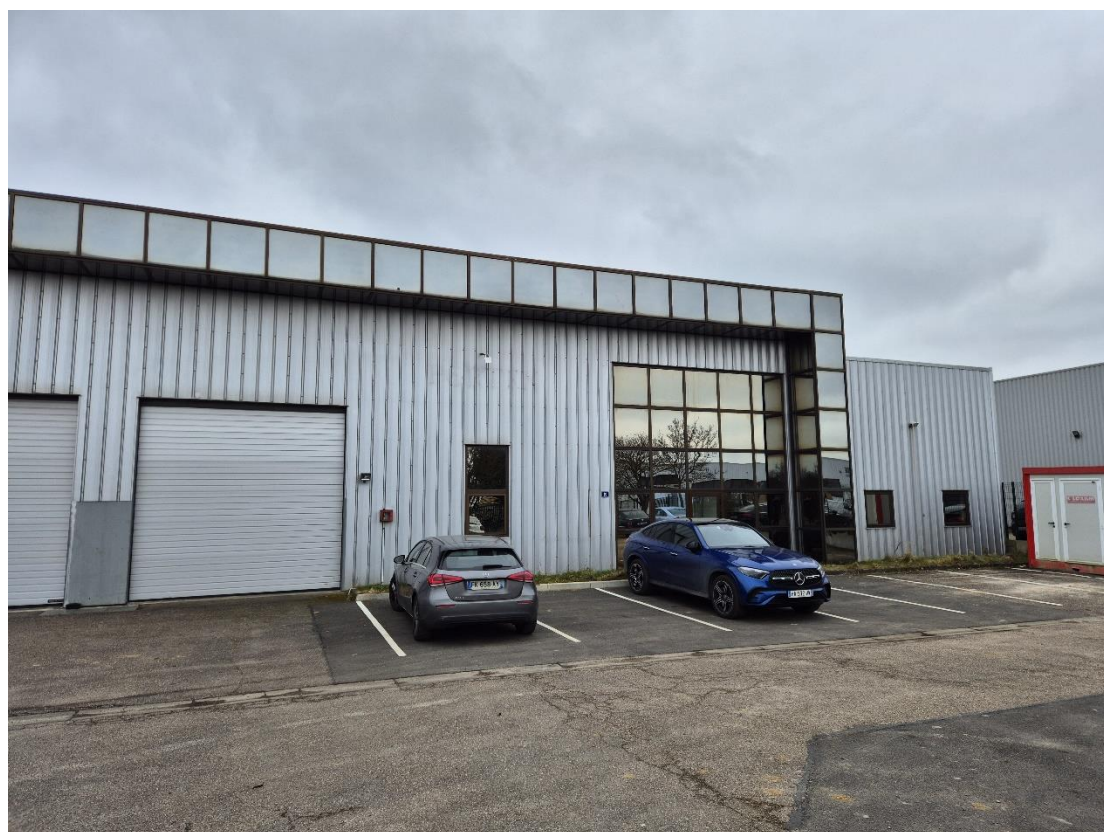
Figure 2 : Face Nord / Accès dépôt + parking macadamisé
