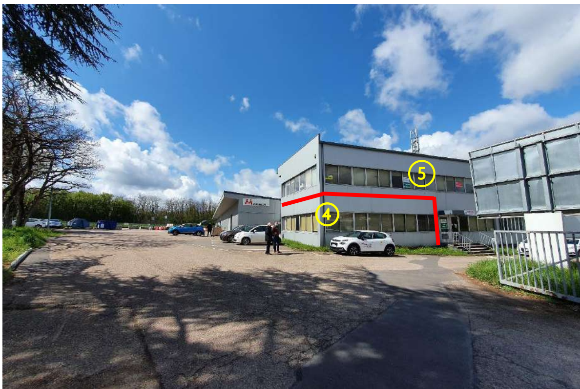
Figure 19 : Lots 4 et 5 / Angle NORD EST / Accès au site + Espaces macadamisés communs
