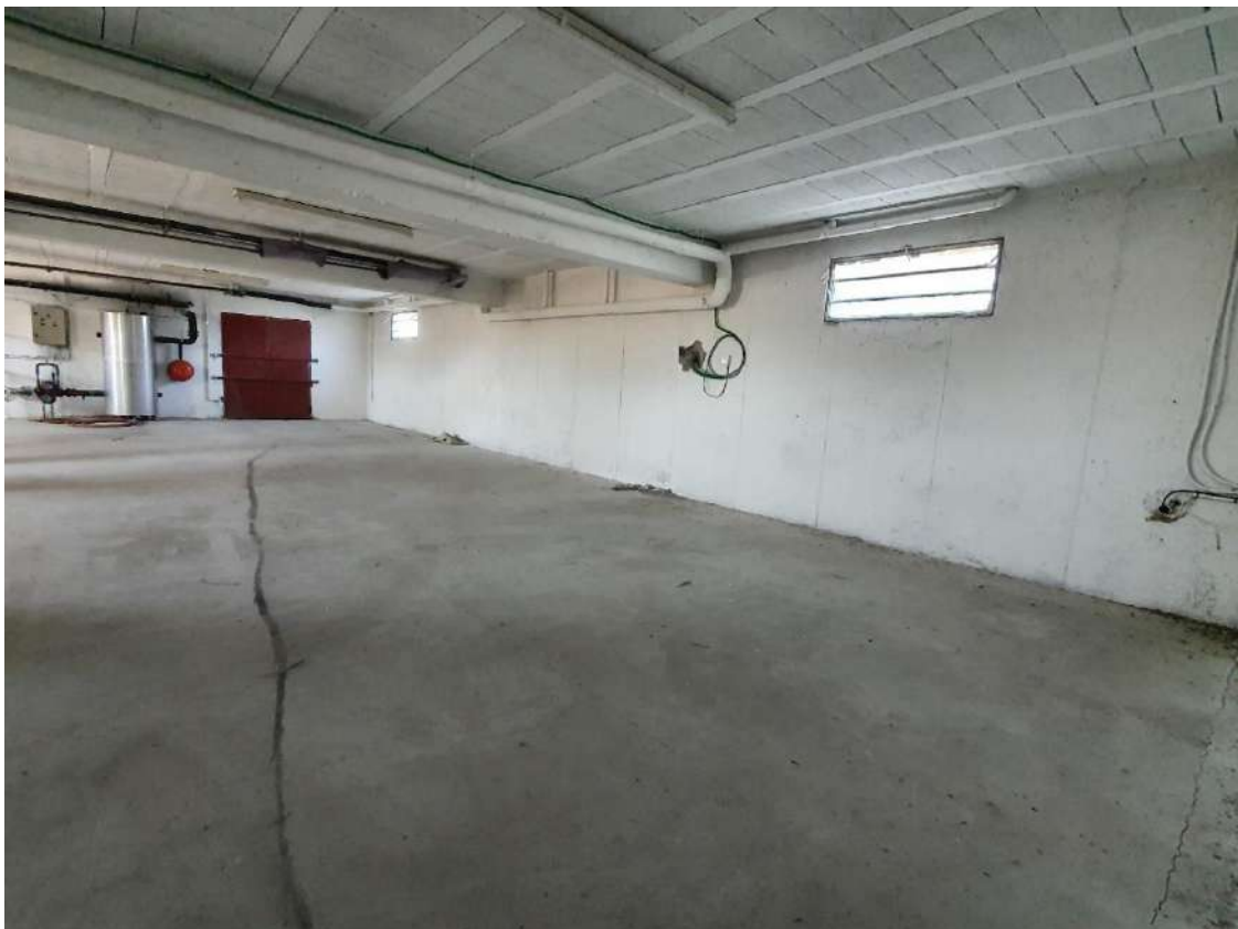
Figure 26: Lot 5 / Stockage et archivage au R-1
