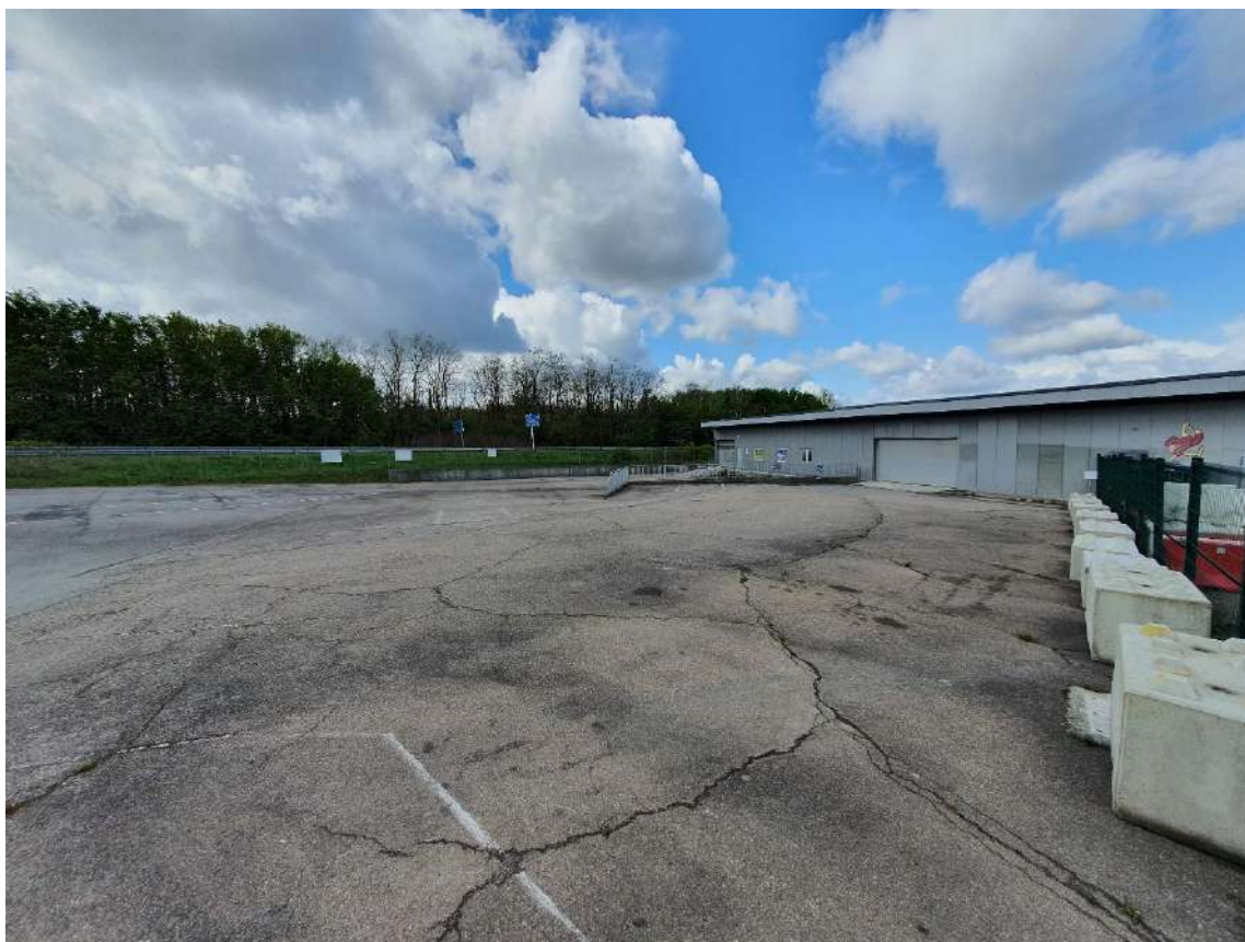
Figure 7: Lot 2 / Face EST / Stockage macadamisé privatif et accueil client
