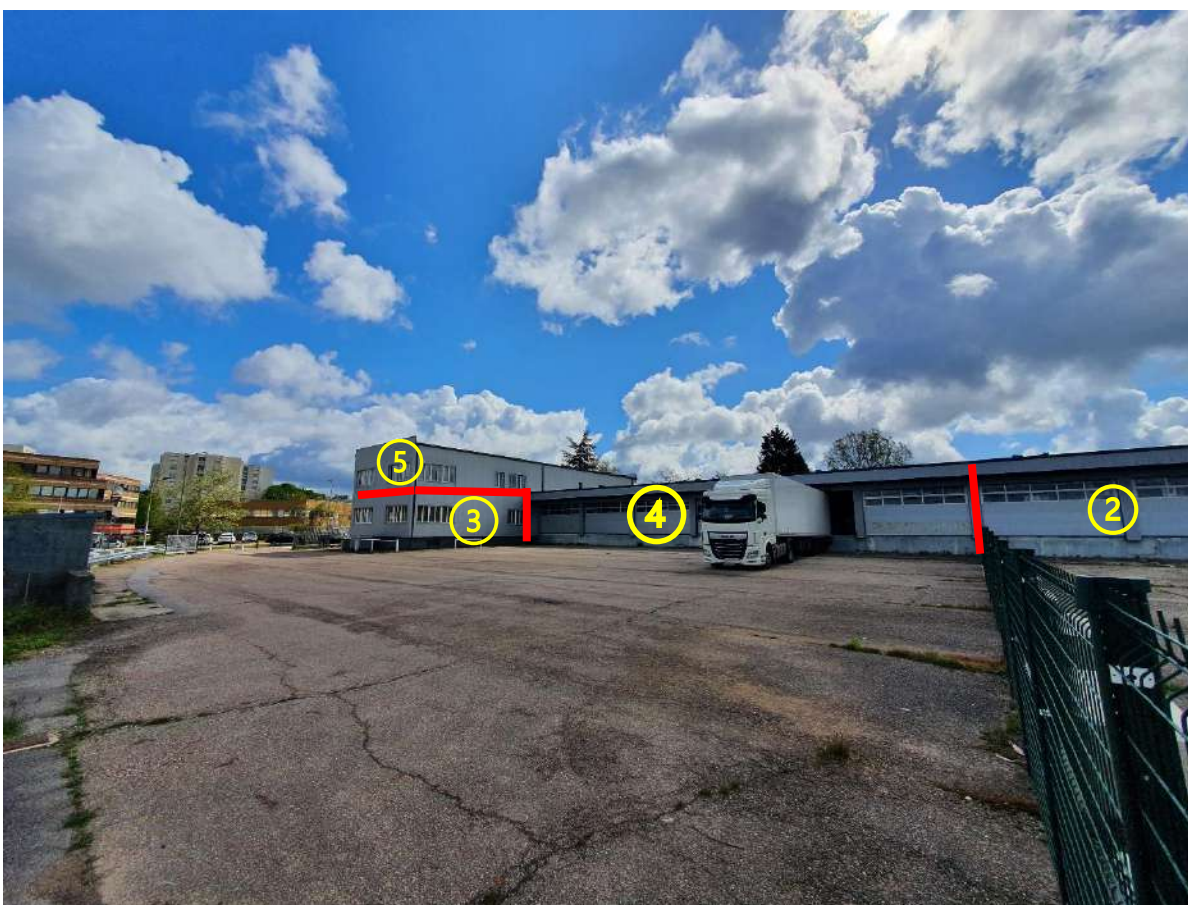
Figure 20 : Lot 4 / Face EST / 6 Quais avec portes sectionnelles automatiques du lot 4 + Espaces macadamisés communs
