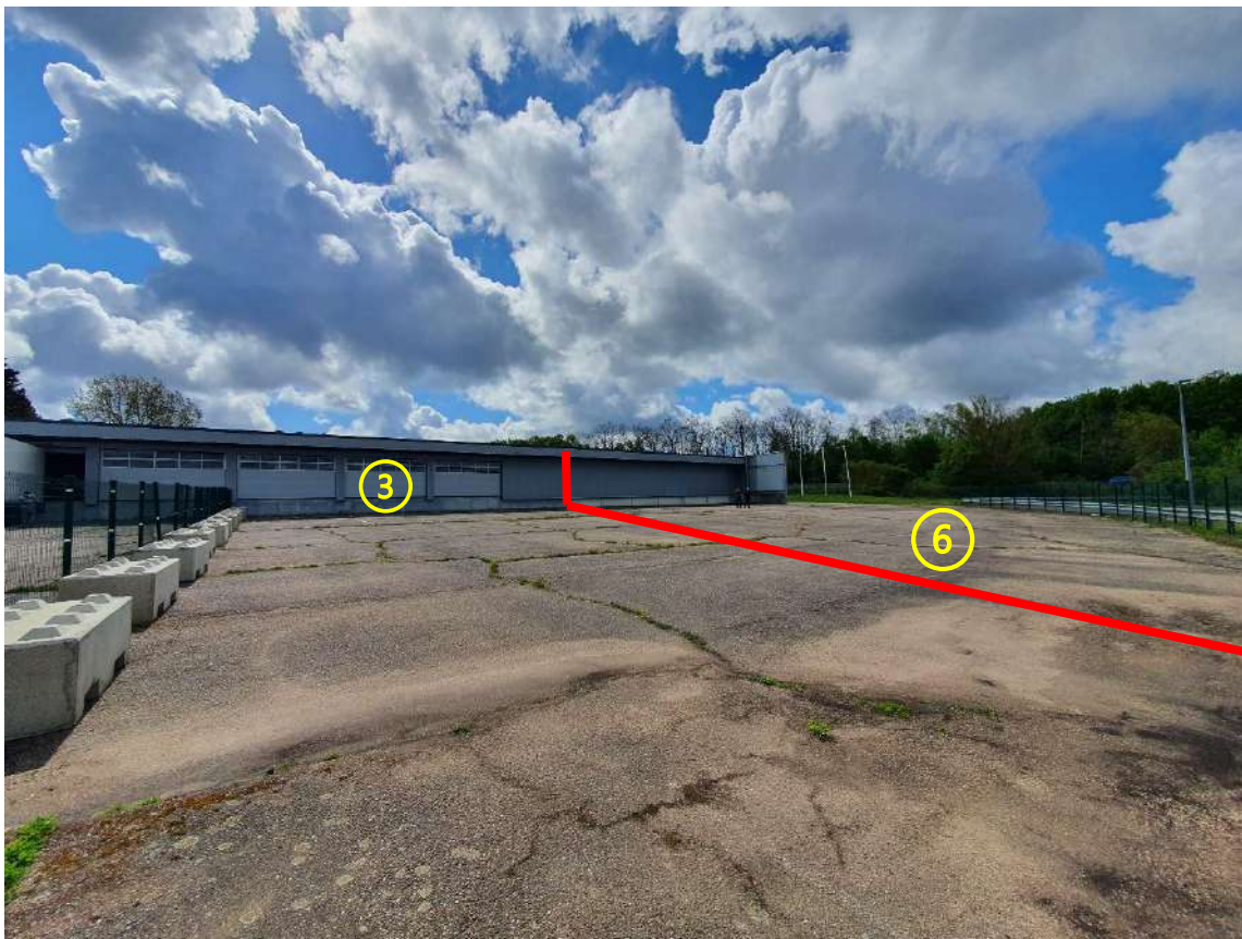
Figure 9: Lots 3 et 6 / Face OUEST / Stockage macadamisé privatif
