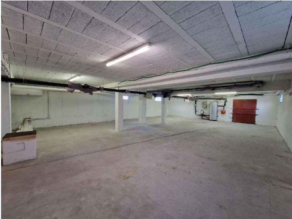
Figure 25: Lot 5 / Stockage et archivage au R-1
