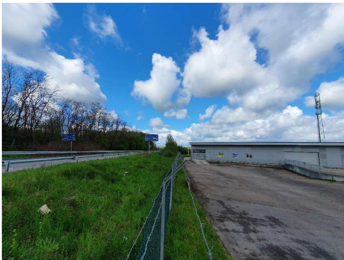
Figure 8: Lot 2 / Face EST / Visibilité voie d'insertion vers A31 + Stockage macadamisé privatif
