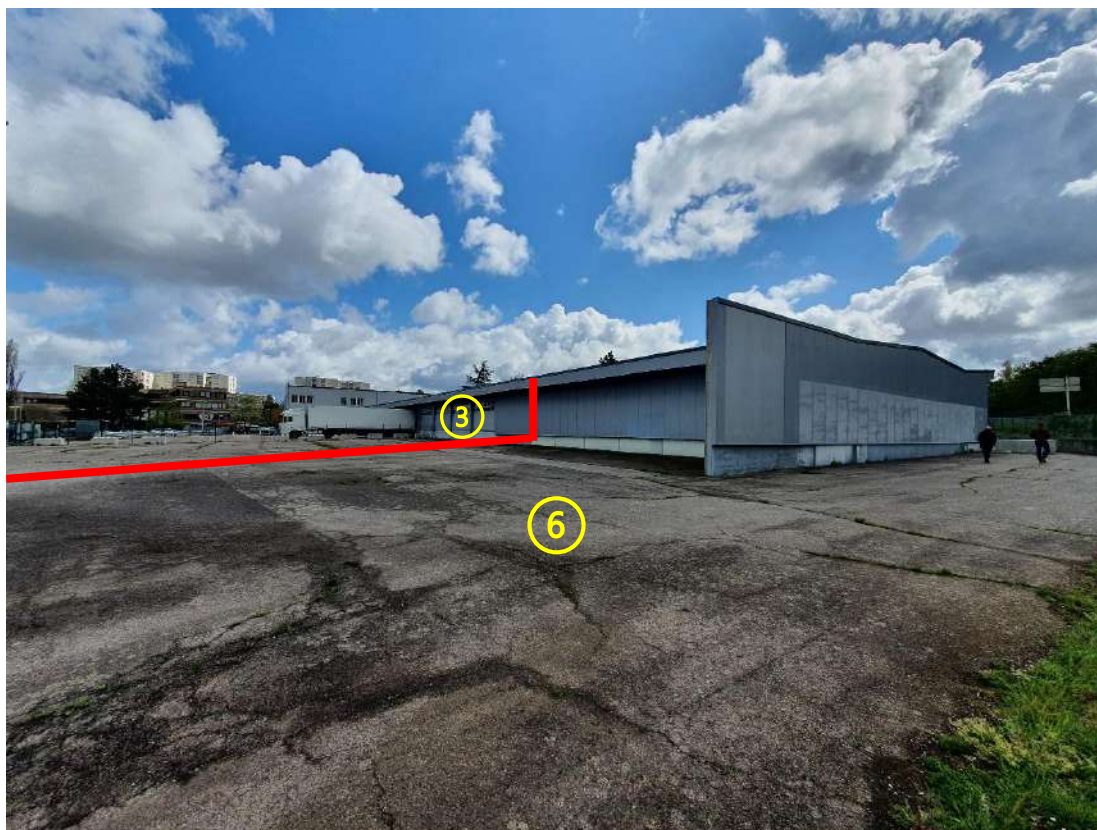
Figure 10: Lot 6 / Face OUEST / Stockage macadamisé privatif entièrement clôturé
